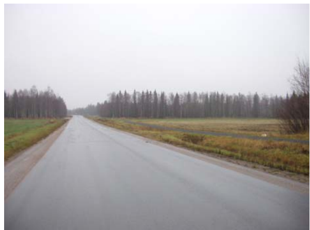
Bild 6.2-2: Köpmansgatan mot öster vid anslutning till planområdet.
